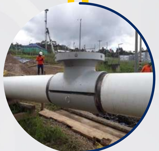
SOLDADURA DE DOS SPLIT TEE EN 20 PULGADAS – API 5 LX 65 PARA INSTALACION DE BY PASS - ESTACION MIRAFLOREZ - TGI - ISMOCOL DE COLOMBIA - AGOSTO 2019
