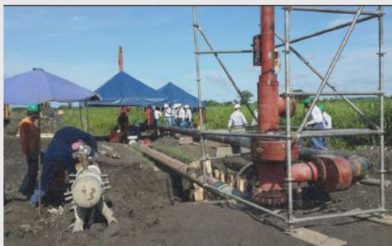
SERVICIO DE STOPPLES CON VALVULAS SÁNDWICH DE 8" X 600 INSTALACION DE VALVULAS DE 8" X 600 PK 785 + 102 AISLAMIENTO DE CRUCES DE RIOS – PERENCO COLOMBIALIMITED – CASANARE
