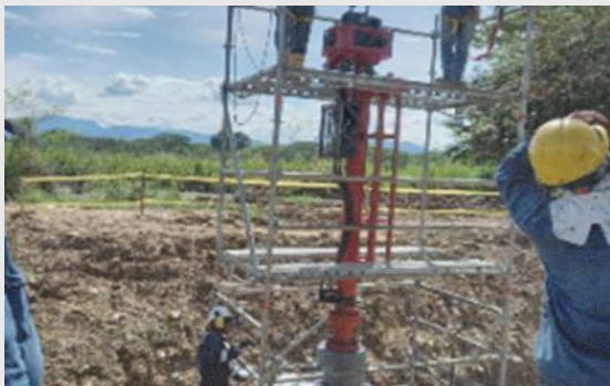
INSTALACIÓN DEL CIEGO AGUAS ARRIBA
