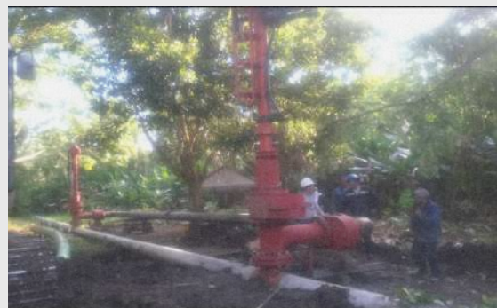
SERVICIO DE STOPPLES CON VALVULAS SÁNDWICH DE 8" X 600 INSTALACION DE VALVULAS DE 8" X 600 PK 785 + 102 AISLAMIENTO DE CRUCES DE RIOS – PERENCO COLOMBIALIMITED – CASANARE
