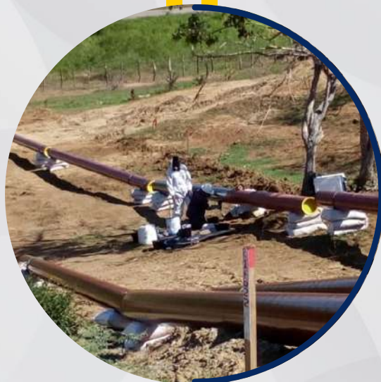
LINEAS DE 6", 8" Y 12" DE HIDROCARBURO CAMPO EL DIFICIL PETROLEOSSUDAMERICANOS - PERFOTECNICA JUNIO - 2018
