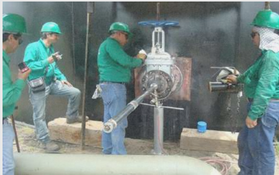
IXCASABE IV ECOPETROL BARRANCA. HOT TAP (PERFORACION EN CALIENTE PARA TANQUES Y LINEAS VIVAS)
