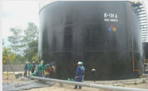
IXCASABE IV ECOPETROL BARRANCA. HOT TAP (PERFORACION EN CALIENTE PARA TANQUES Y LINEAS VIVAS)
