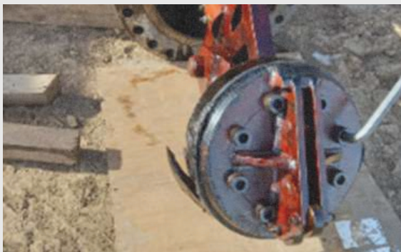
DESENSAMBLE DE CABEZAS OBTURADORAS
